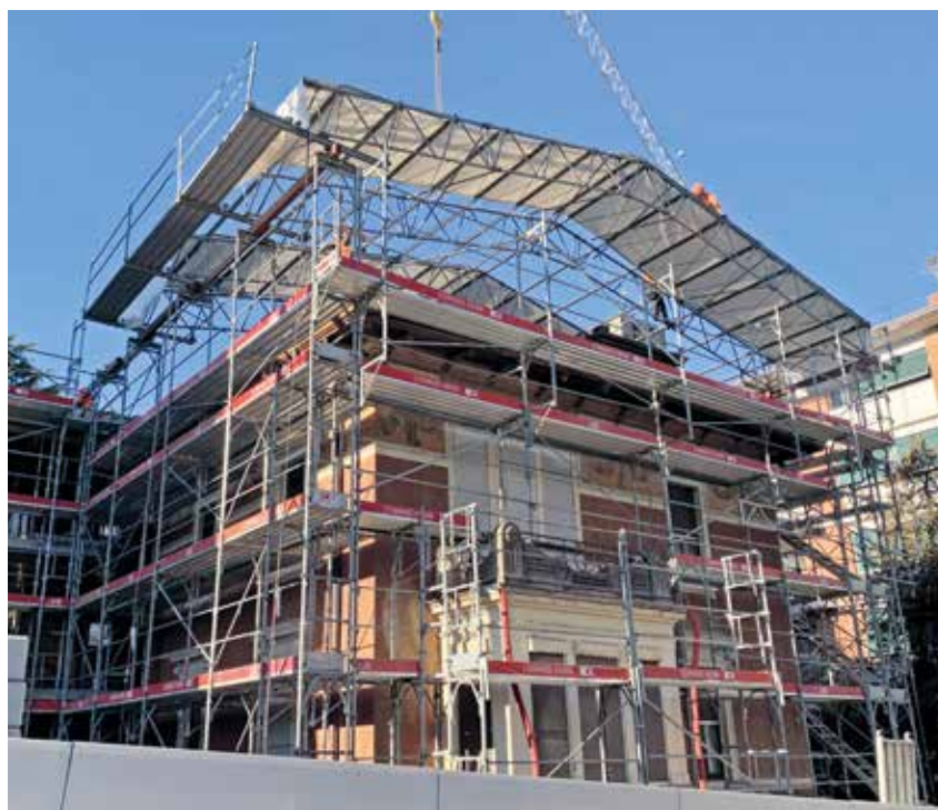
Il cantiere di Casa Dorotea (nella foto: i lavori a fine febbraio) è in questo momento lo sforzo prioritario che caratterizza la nostra parrocchia.
